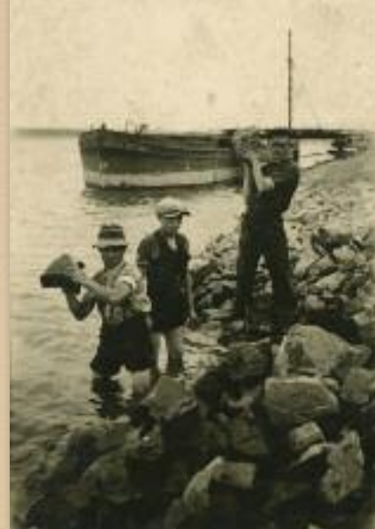
Polnische Zwangsarbeiter beim Kanalbau in Wedtlenstedt, 1941 (AFPNP)
