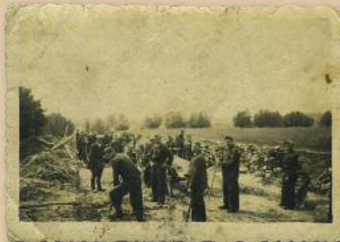
Straßenbauarbeiten durchgeführt vom Baudienst, Wąchock, 1942 (AFPNP)
