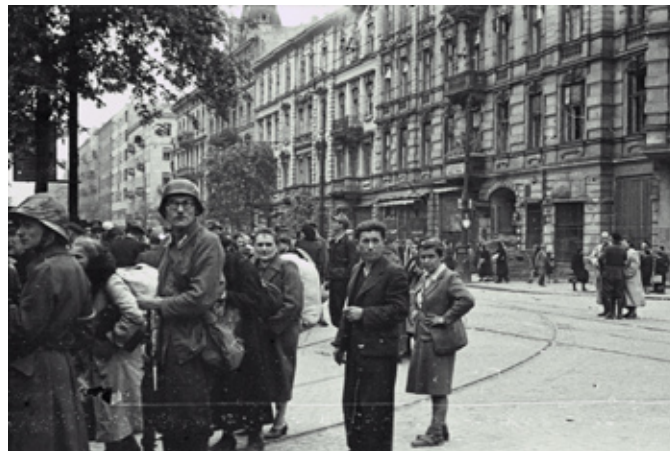
Powstańcy regulujący ruch ludności cywilnej w czasie ewakuacji w dniach 7-10 września 1944 r. przed barykadą u wylotu ul. Śniadeckich na ul. Marszałkowską. W tle widoczna zabudowa ul. Marszałkowskiej pomiędzy ul. Koszykową i Piusa XI, wrzesień 1944, fot. Marian Grabski
