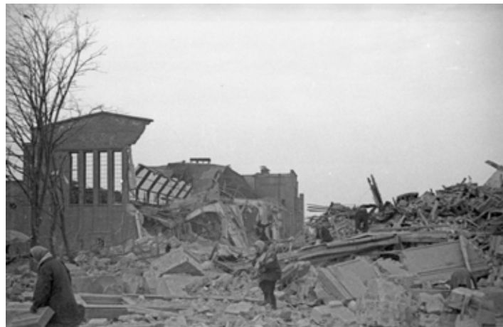
Pozostałości hali produkcyjnej na terenie kompleksu fabryki Państwowych Zakładów Inżynierii w Ursusie, styczeń 1945, fot. Eugeniusz Haneman
