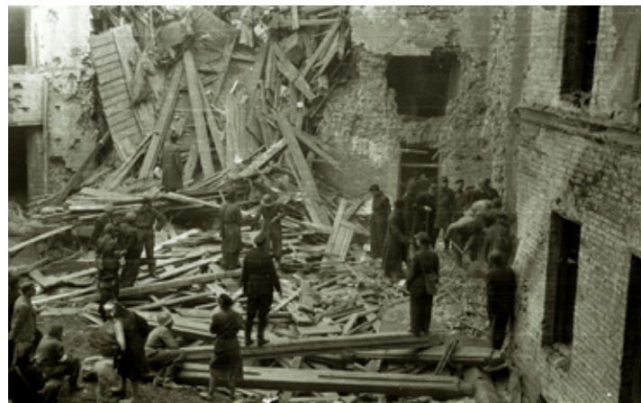
Grupa żołnierzy i ludności cywilnej na gruzach zbombardowanej kamienicy przy ul. Wilczej 32. Widok od strony podwórza, wrzesień 1944, fot. Wiesław Chrzanowski
